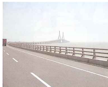
延々と続く東海大橋
